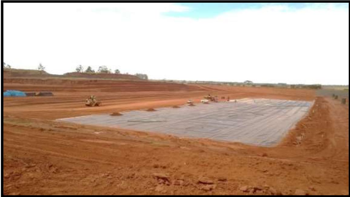
Figura 51 - Preparação de uma vala, com manta impermeabilizante
