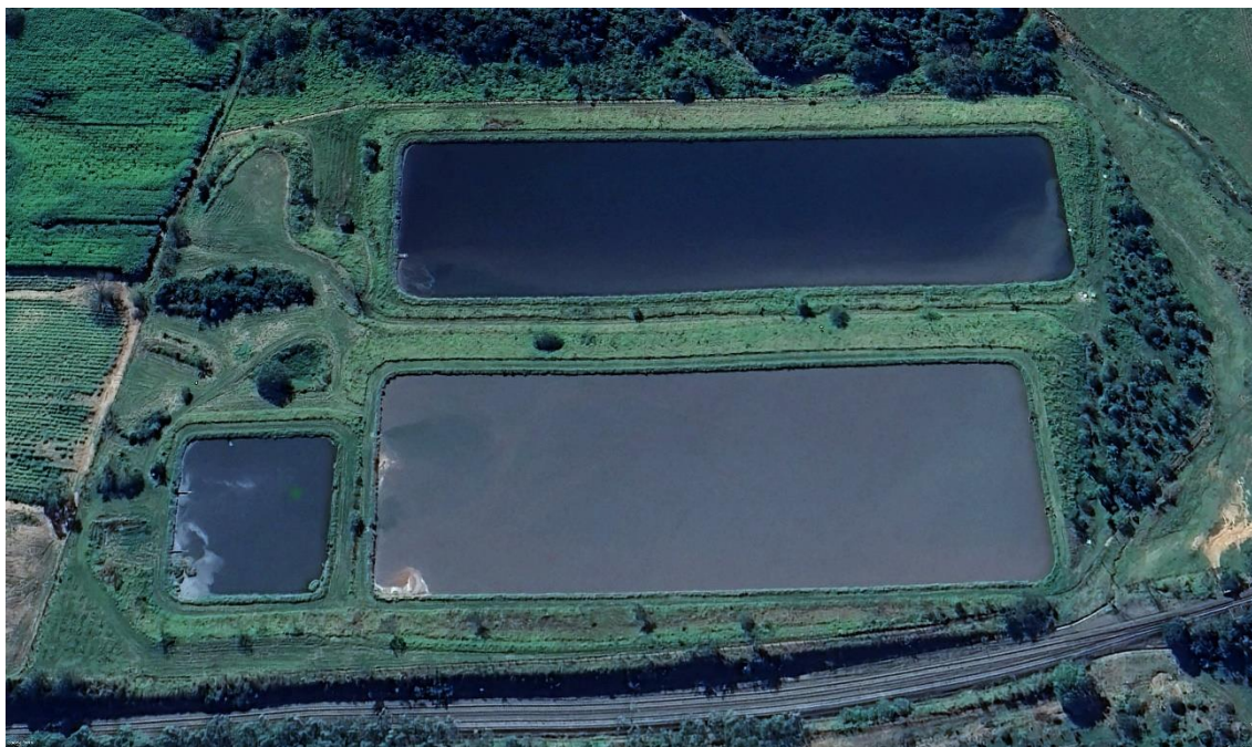
Lagoa de tratamento de esgoto do município de Uchoa. Fonte: Google Earth Pro.
