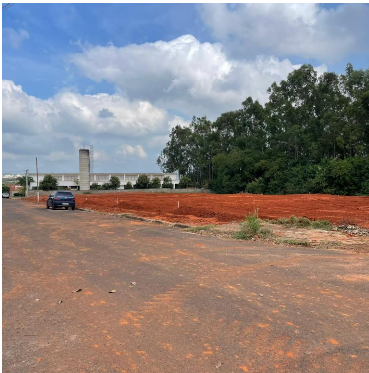
Figura 2 - TERRAPLANAGEM DA ÁREA
